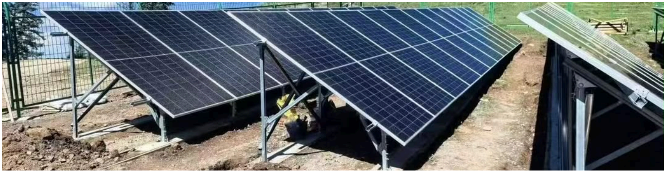
ภาพอ้างอิง: โตะแผงติดตั้งบนพื้นดินแบบสองขา ประเภทเดียวกับที่ครอบคลุมในรายการวัสดุนี้
