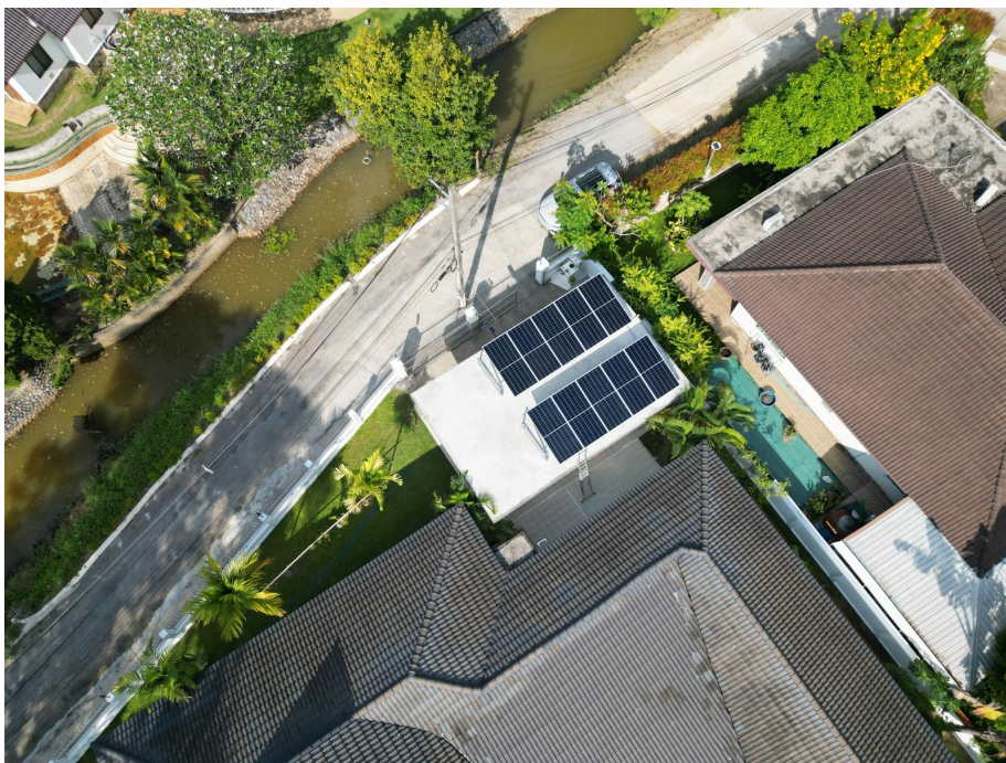
10 panelen (6.500 kWp) op het dak van de carport, luchtfoto na de installatie.
