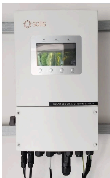
Hybride omvormer van Solis. De DC-schakelaar is de zwarte draaiknop aan de linkerkant.
