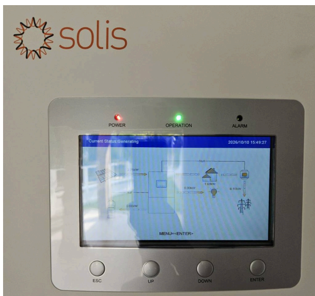
Display en controlelampjes van de omvormer bij normale werking.
