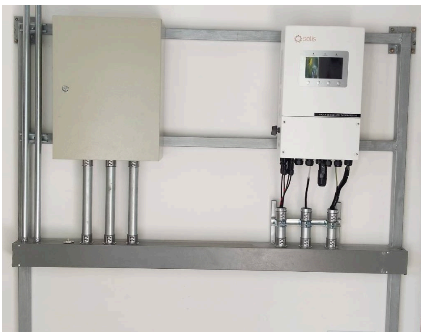
Schakelkast (links) en hybride omvormer van Solis (rechts) op het verzinkte stalen frame.
